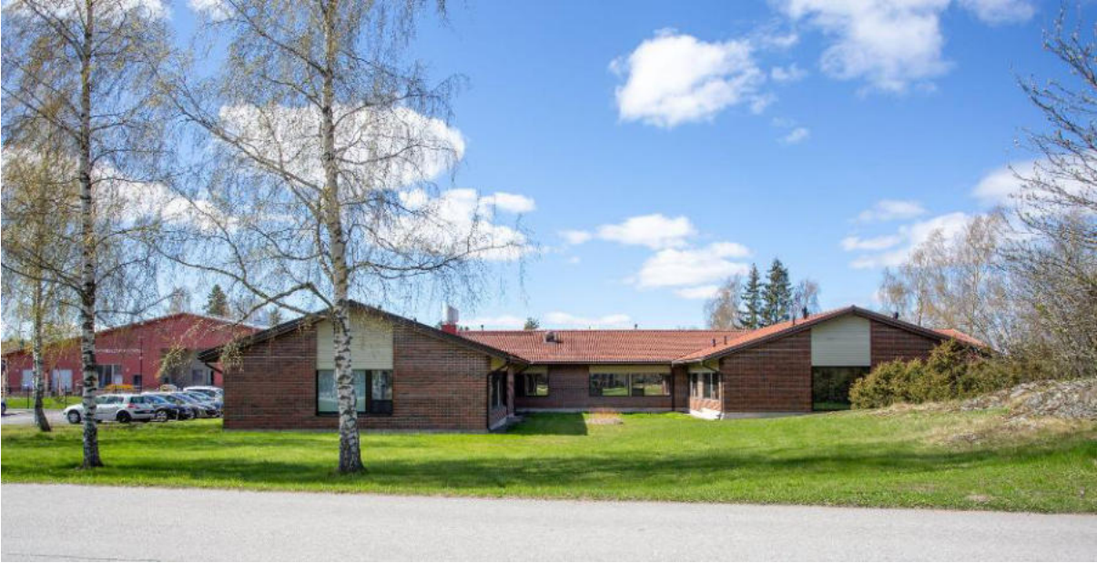
Näkymä Ruskon terveyskeskukselle Vanhalta tieltä. Kampamainen rakennustyyppi toistui myös jo puretussa vanhassa päiväkodissa, joka sijaitsi uuden päiväkodin paikalla.
