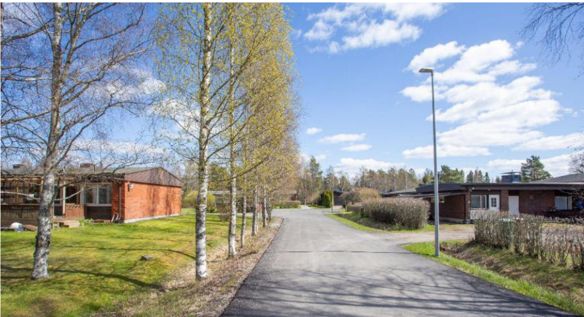
Lähipalvelujen alueelta ja Ruskon keskustan tästä osasta poikkeaa kaksi pihatietä 1970- ja 1980-lukuisille rivitaloalueille. Näkymä ei kuulu suunnittelualueeseen, mutta kyseisten vuosikymmenten matalaprofiilinen rakennustyyli on koko keskustalle leimaa antava ominaispiirre.
