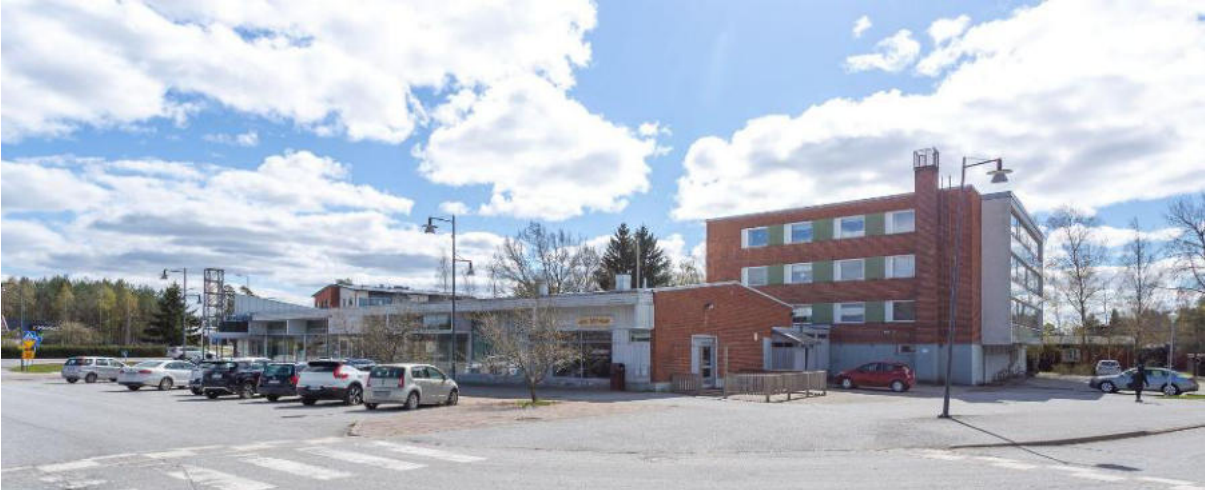
Näkymä Vanhalta tieltä As oy Ruskon liikekulman suuntaan. Kyseinen rakennuskokonaisuus muodostaa vastinparin As oy Ruskolalle. As oy Ruskon liikekulmassa on nähtävissä jo asunalähiöille tyypillistä punatiliulkisivua, joskaan 1970-lukuisena se ei kuitenkaan edusta vielä elementtitekniikkaa.
