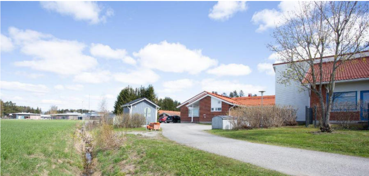
Pellon ja palveluasuntojen liitoskohtaa. Näkymä pohjoiseen.
